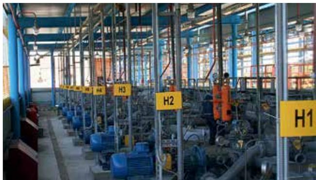
**Рис. 5.7.** Реконструированная на комбинате в рамках ФАИП система контроля загазованности и оповещения об аварийных утечках аммиака
