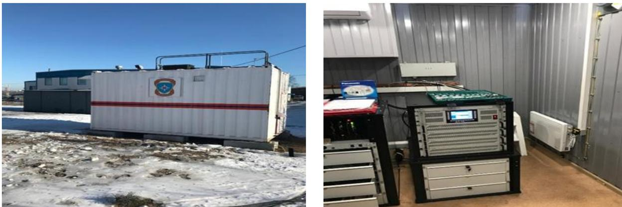
Рис. 6.37. Современная цифровая КВ радиостанция контейнерного типа
