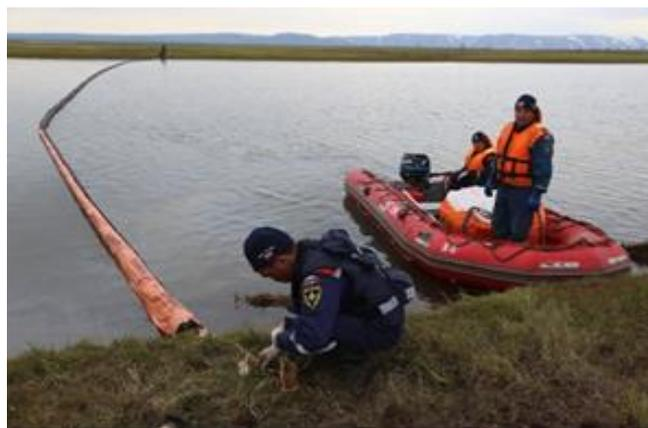
**Рис. 6.6.** Установка боновых заграждений
