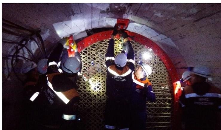
Рис. 3.39. Установка защитного комплекса от воздействия воздушной ударной волны
