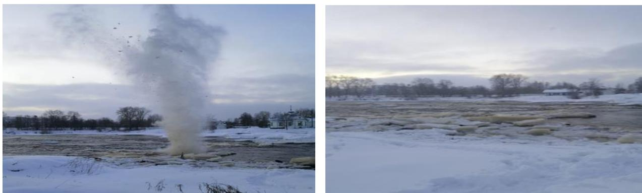
Рис.1.26. Ликвидации ледяных заторов
