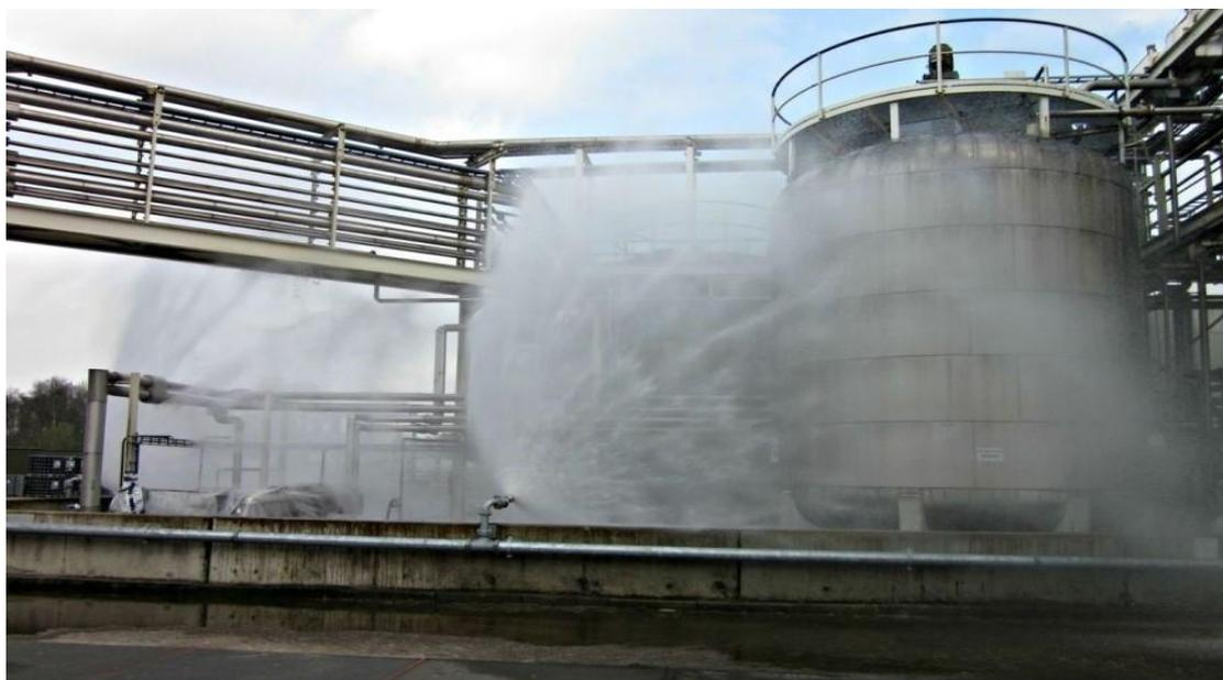
Рис. 4.8. Работа системы водяного орошения на объекте защиты
